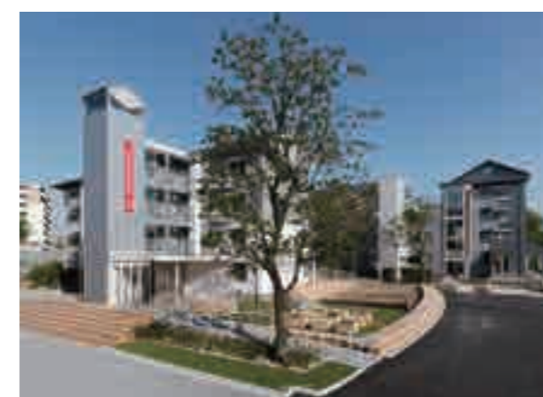
写真1 団地再生プロジェクト(大阪府堺市西区)
