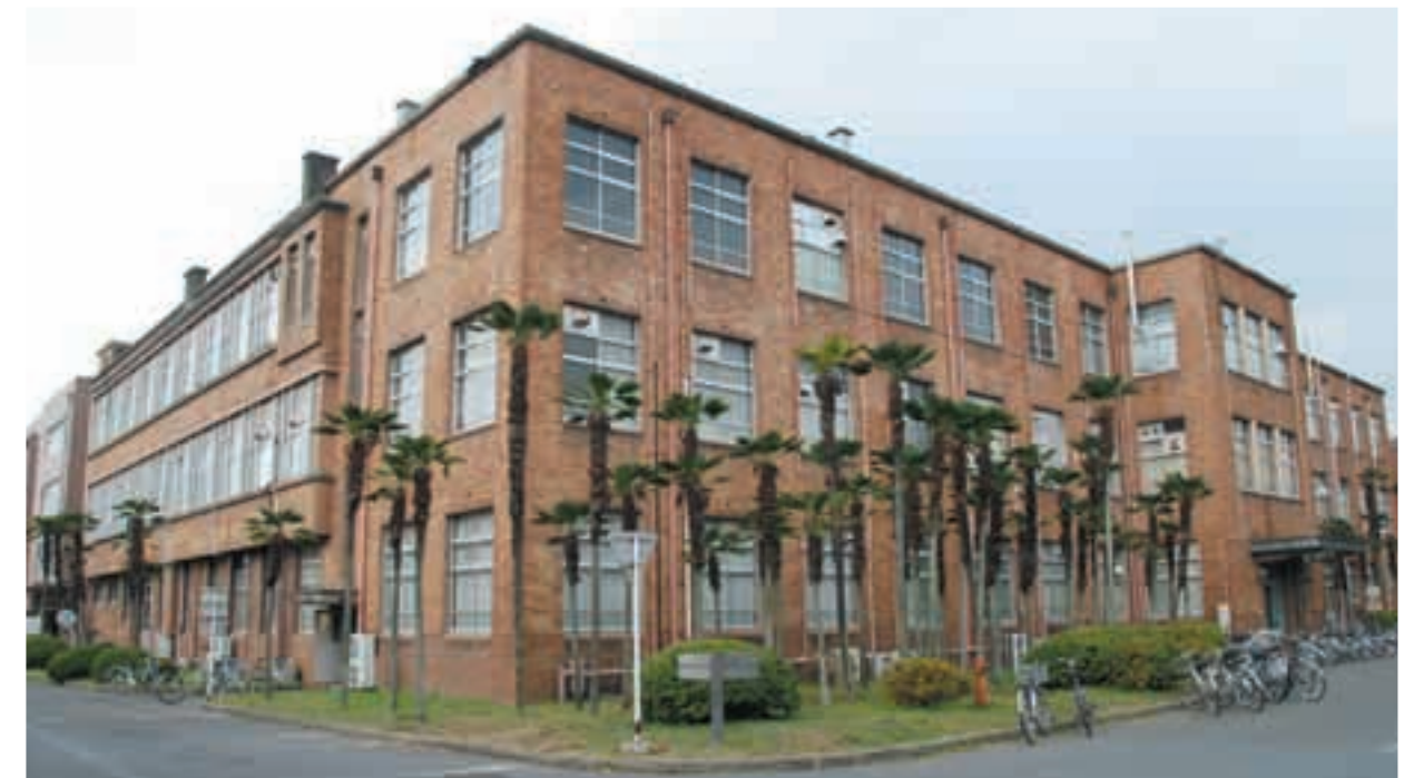
本館及び講堂（現・3号館）
