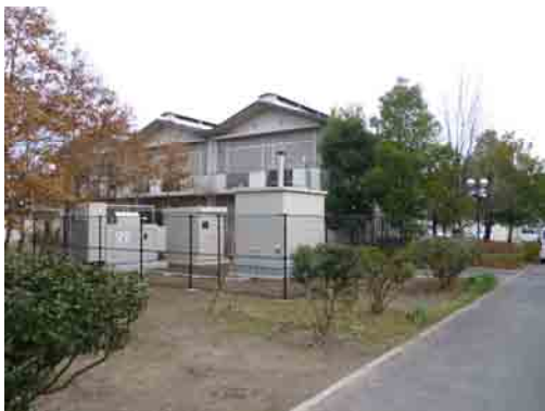
<嵯峨・自家発電設備>
