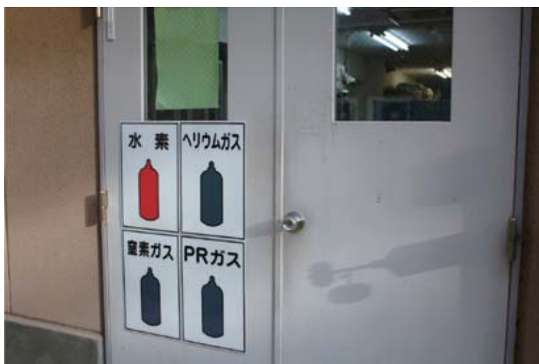
保管している高圧ガスの表示
