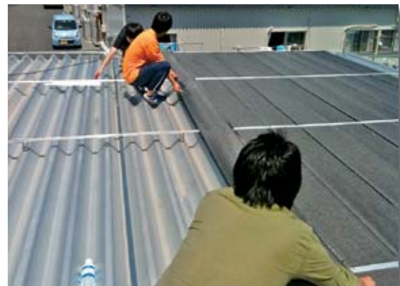
仮設住宅屋上の緑化作業と断熱シート貼り
