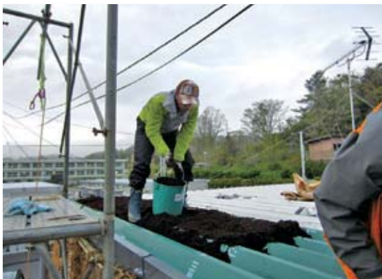
仮設住宅屋上の緑化作業と断熱シート貼り
