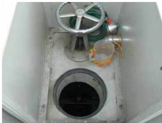
東地点排水口 内部
