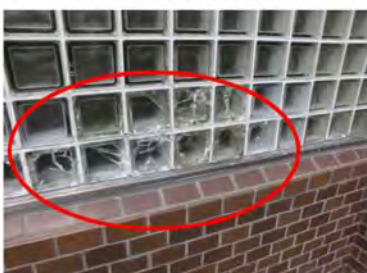
※老朽建物外壁(築49年)
