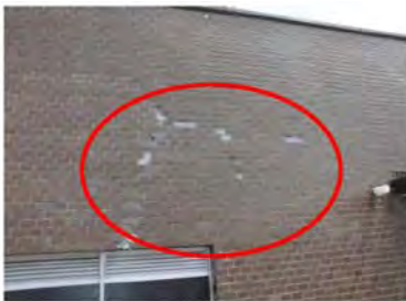
※老朽建物外壁(築44年)
