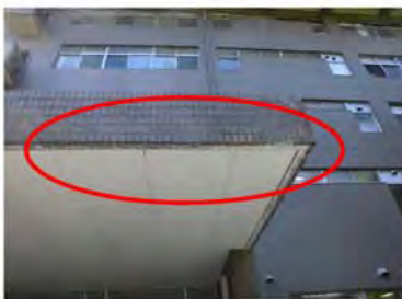
※老朽建物玄関庇(築50年)
