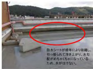
※老朽建物防水(築44年)
