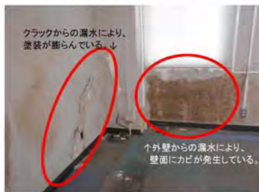
※老朽建物外壁(築50年)
